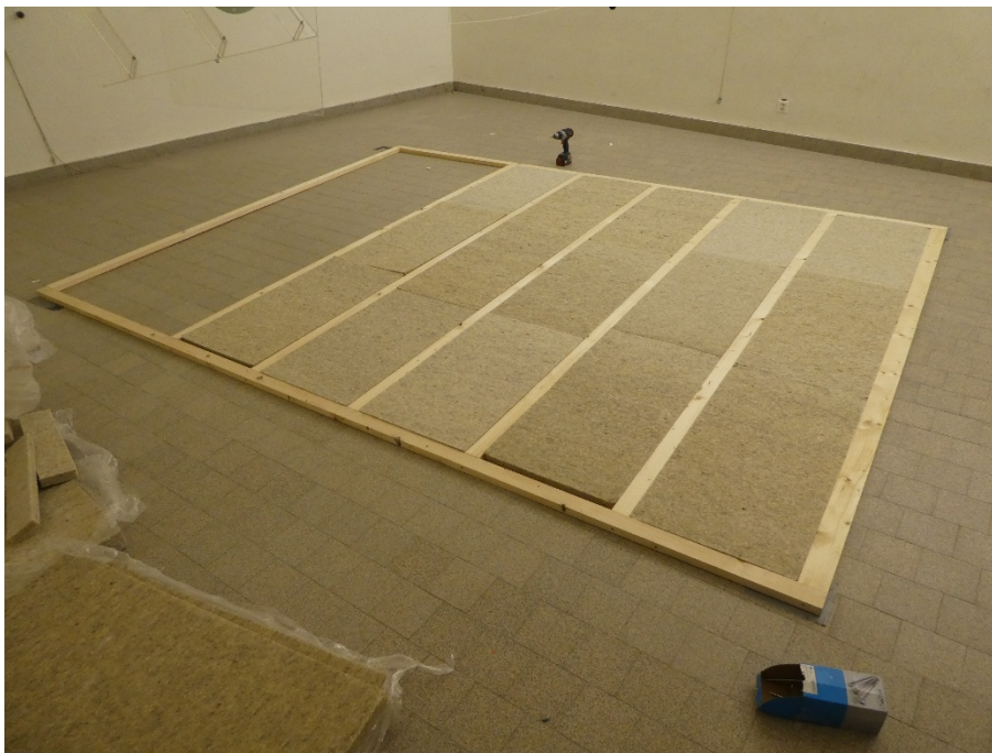
Abbildung 2: Aufbau von Prüfobjekt 1 auf dem Hallraumboden
